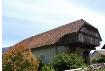
Forte avancée de toit sur le mur pignon augmentant la surface de stockage – ferme à Charvonnex (Doucy)
