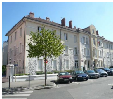
Immeuble remarquable de style régionaliste et Art-Déco en pierres apparentes jusqu'à mi-hauteur de la façade, décor saillant et mouluré marquant les encadrements de fenêtres, bandeaux filants aux étages. Avancée de la partie centrale. – 1-3 rue de l'Intendance, Annecy (1ère moitié XXè s). Photo PLU d'Annecy
